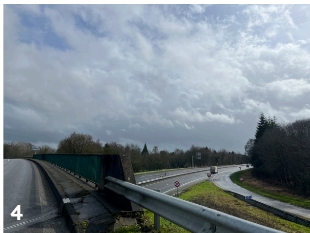
4 Périètre d'étude vu depuis le nord-ouest - Source : CITTANOVA
