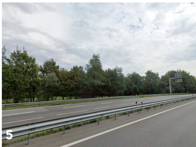
5 Périètre d'étude vu depuis la RD 137 - Source : Google Streetview
