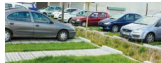
Noue végétalisée avec infiltration gravitaire du ruissellement
