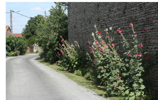
Pieds de murs végétalisés
