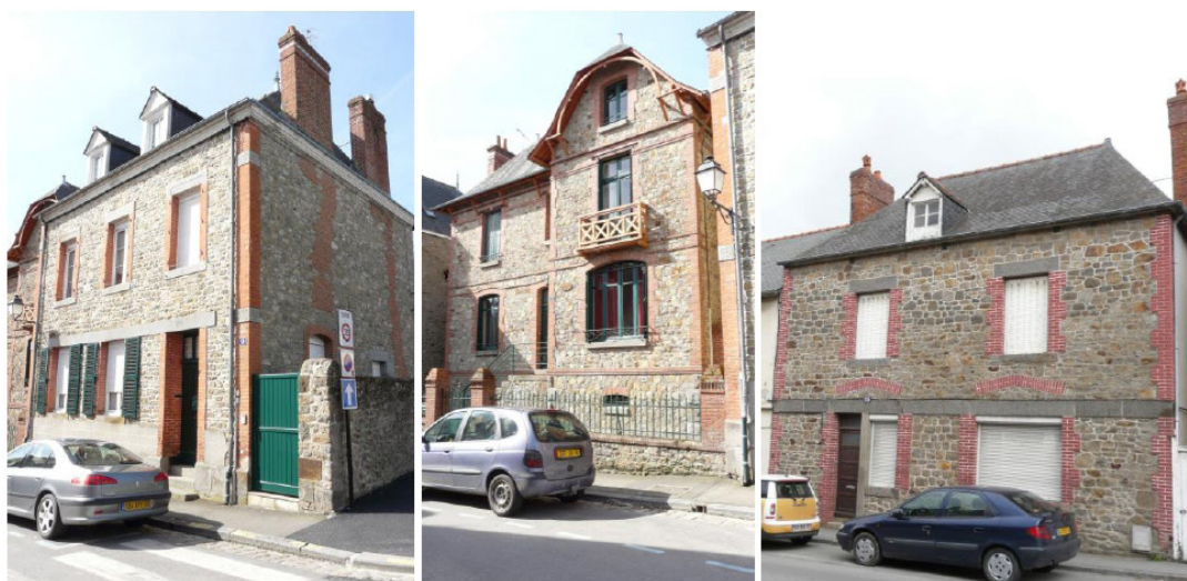
FACADES AVEC DECORS EN BRIQUES
