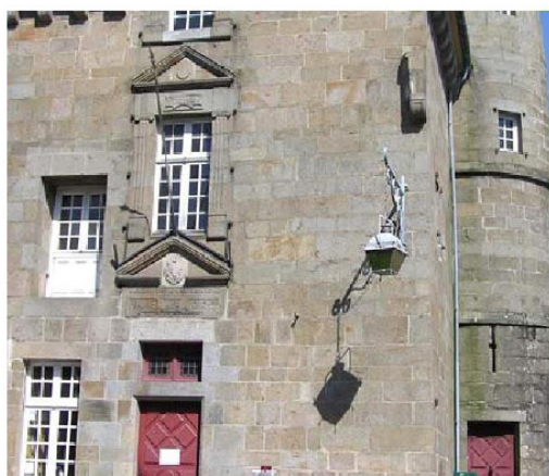
Maçonnerie de granit en pierre de tailles régulières jointoyées
